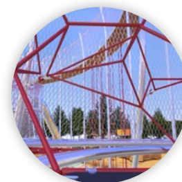
11 Перекрестное соединение канатов двойными S-образными стальными крючками
